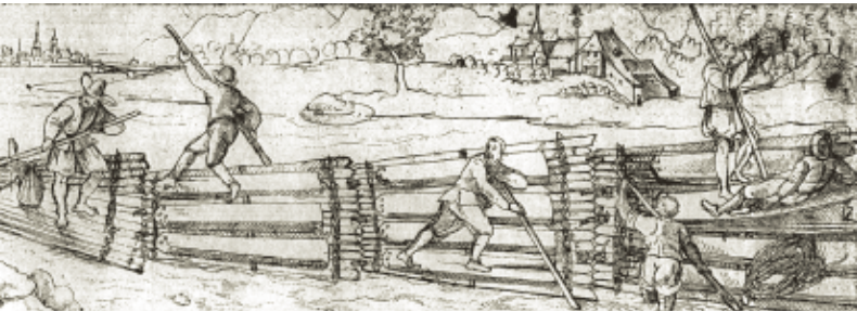
Die ältesten Darstellungen der Flößerei (um 1600): Flößer steuern ein Gestörfloß aus der Kinzig in den Rhein, links Straßburg
