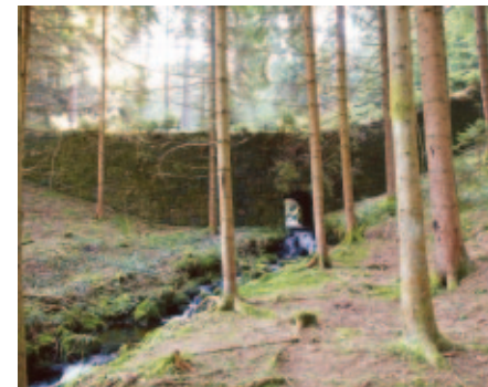
Reste einer Sandsteinmauer, die als Unterbau einer Holz-Riese bei Bad Rippoldsau Verwendung fand
